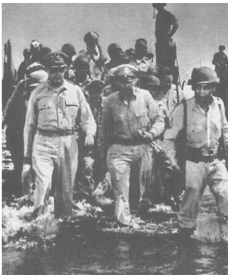
Il generale Douglas MacArthur (1880-1964) mantenne la promessa. Eccolo (il primo da sinistra) di ritorno nelle Filippine insieme con il generale Sutherland.
